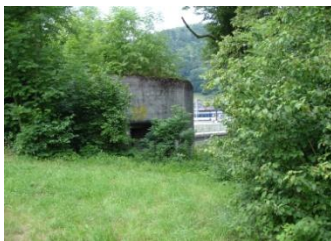
Bunker bei Ziegelbrücke
